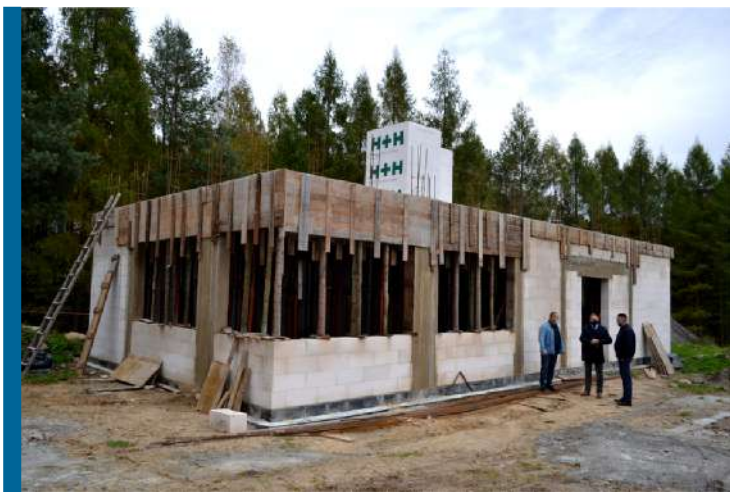
Budowa Świetlicy w Ciechostowicach
