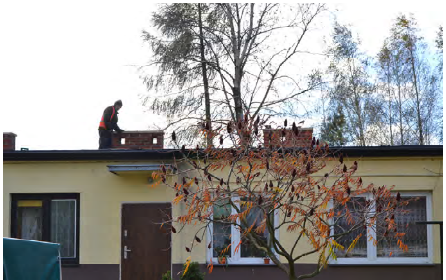
Remont dachu budynku, który został wybudowany jako pierwszy
