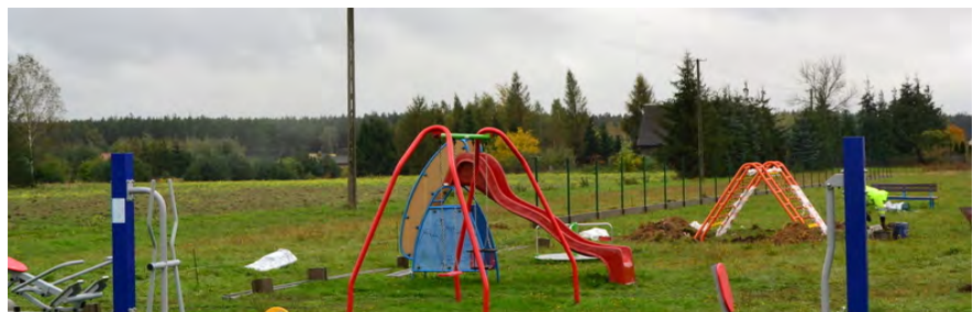
Ogrodzenie przy nowym placu zabaw w Baraku
