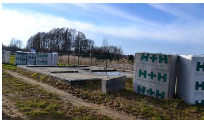
Budowa świetlicy w Chustkach
