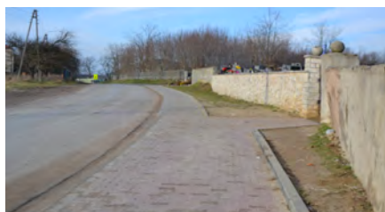
Chodnik i zatoka w Wysokiej
