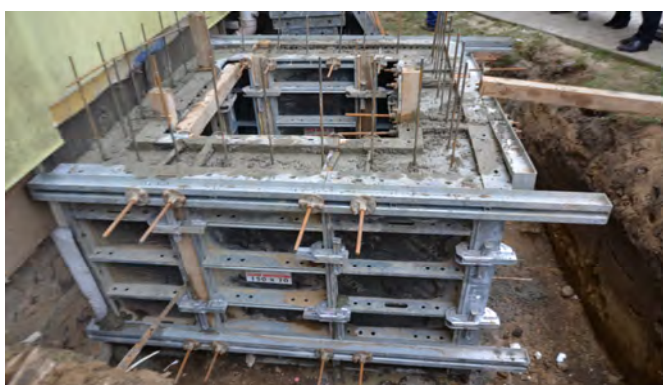
Rozpoczęto montaż windy przy PSP nr 1 w Szydłowcu
