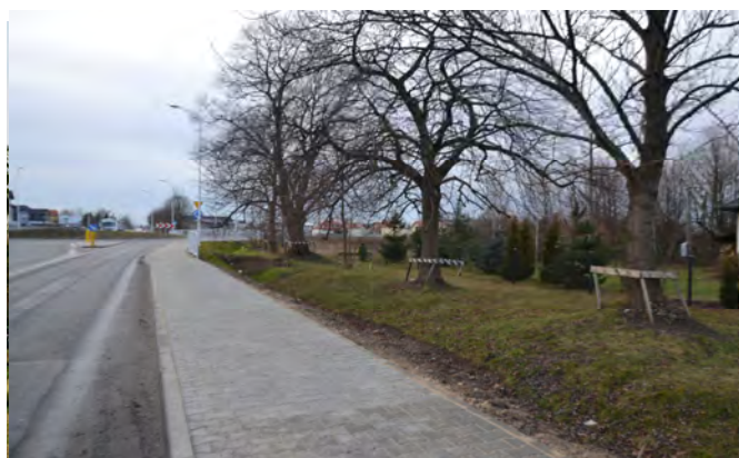
Dokończony chodnik przy ul. Kościuszki
