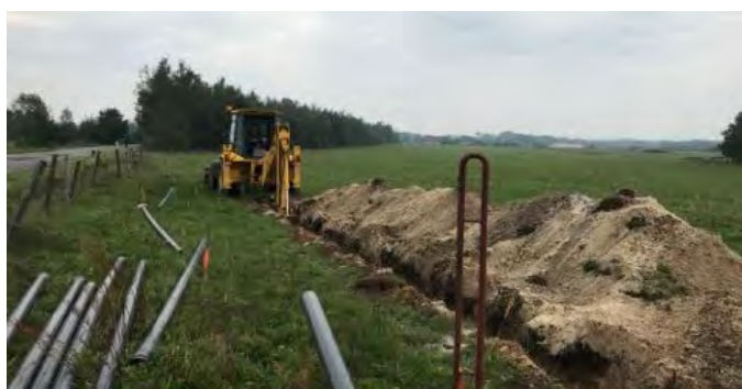
Budowa sieci wodociągowej w ul. Metalowej
