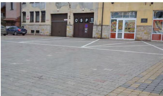
Remont nawierzchni placu OSP w Szydłowcu
