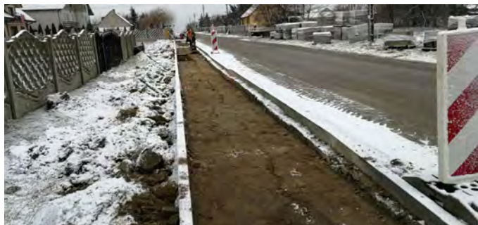
Budowa chodnika w Szydłowie
