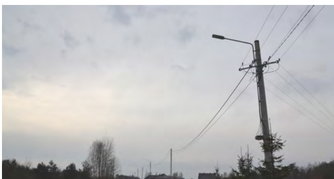
Nowe lampy przy ul. Metalowej
