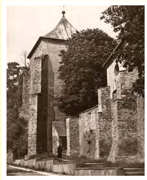
Dzwonnica kościoła św. Zygmunta od strony ul. Kamiennej, lata 60 XX w.
