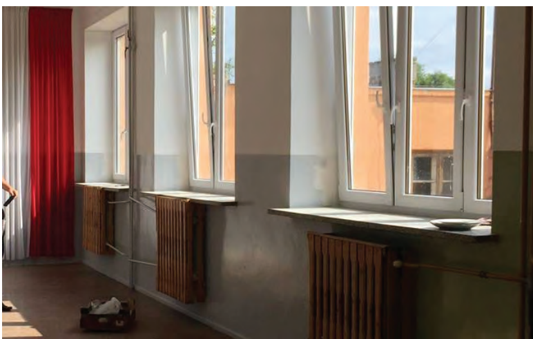
W szkole podstawowej w Wysokiej zamontowane zostały nowe okna.
